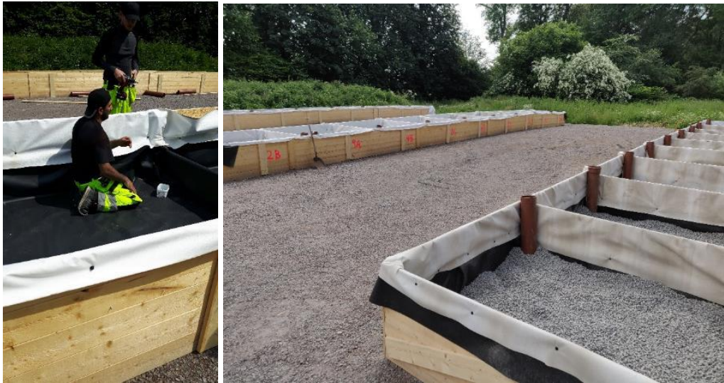
Figur 2.3 Byggnation av odlingslådor. Till höger: stenkross som dräneringsskikt och dräneringsrör.
