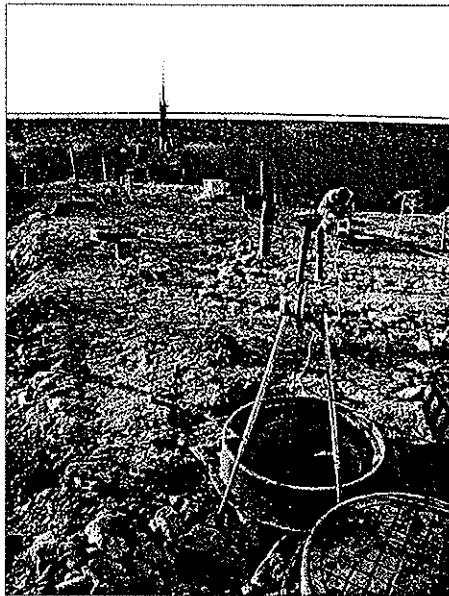
Figur 6-31 Mätning med Minisonde i massförstärkt torv under provbank i Enånger.
