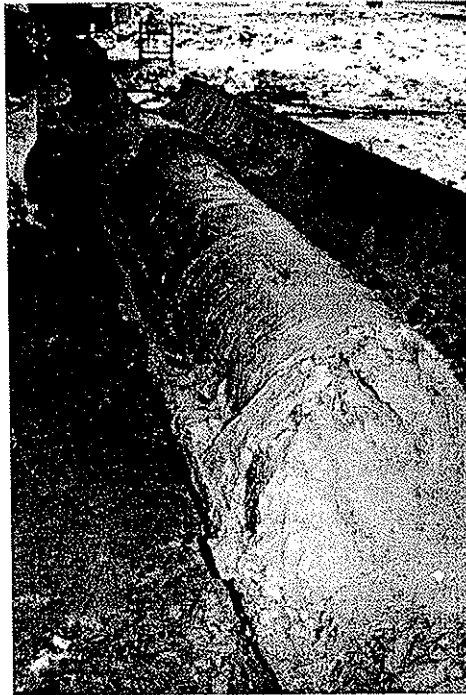
Figur 5-10 Upptagen pelare, 600 mm, intakt.
