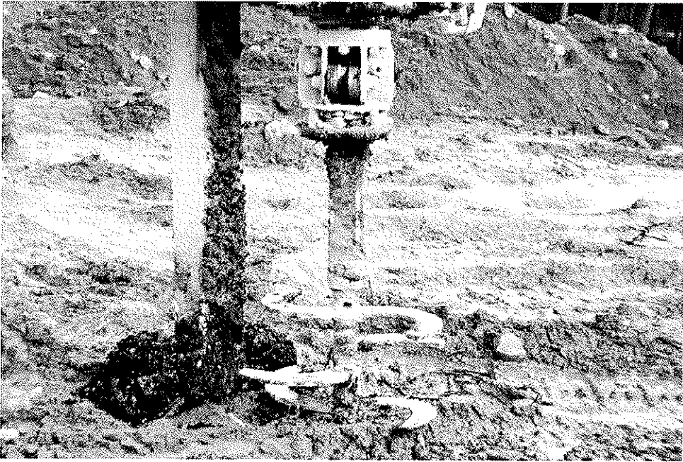
Figur 23 Modifierat KC-blandningsverktyg som användes för cellstabilisering
