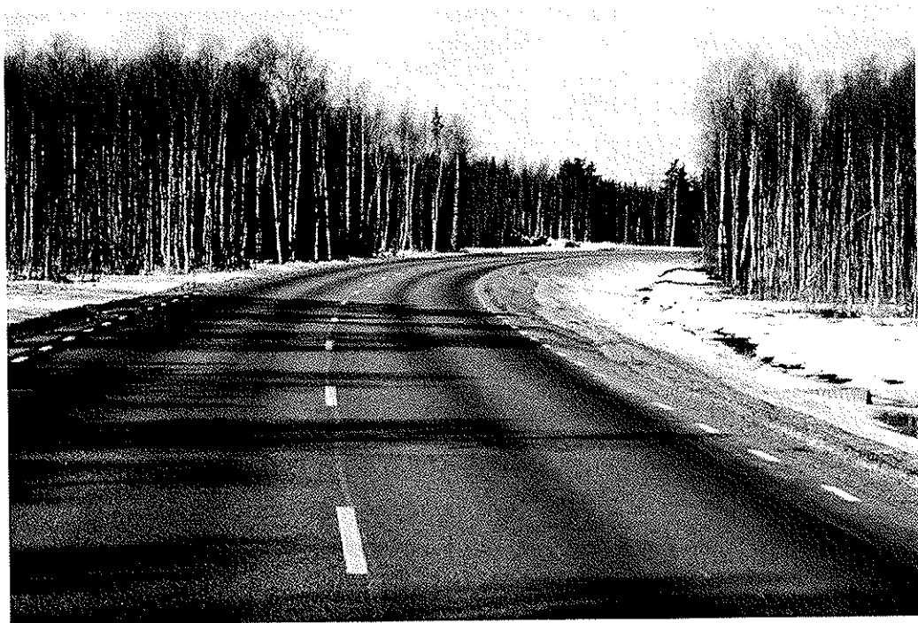
Figur 19 Färdig väg, väg 601, Sundsvägen, Råneå (35)
