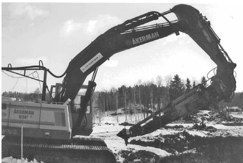
Figur 7.3. Exempel på utrustning med inblandningsverktyg för masstabilisering.
