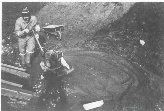
Figur 13. Packning av det grustäckta lerskiktet.
