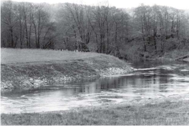
Exempel på erosionsskydd med samkross (Kåhög).
