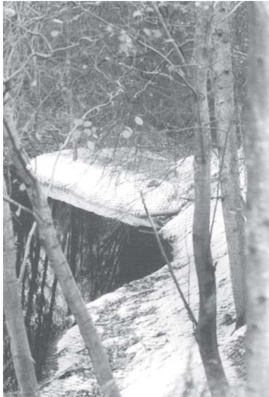
Exempel på erosionsskydd med betongmadrass (vid tennishallen, Kinna).
