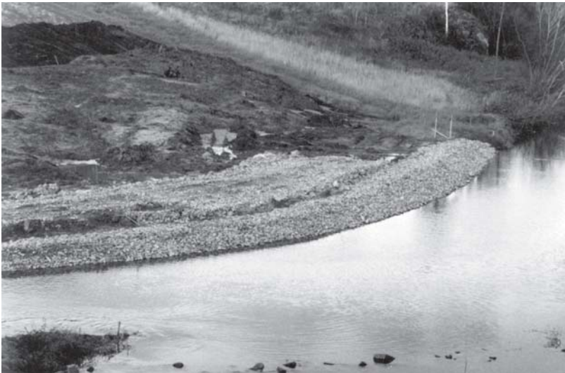
Exempel på erosionsskydd från Marks kommun.
