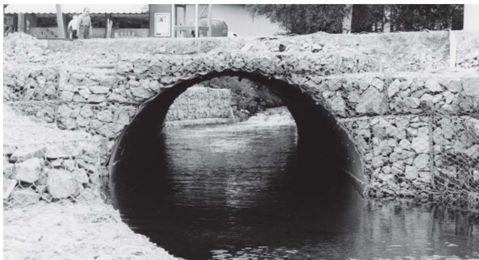
Exempel på användning av gabionkassar (SWEGAB, Höganäs).
