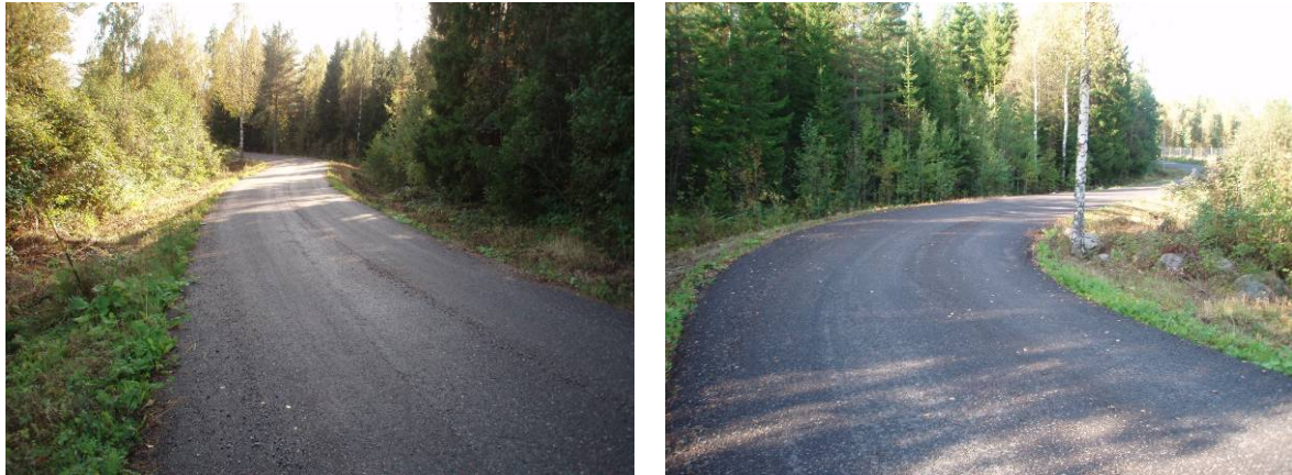
Figur 2. Tio år gammal väg på Ulvbergets avfallsanläggning utanför Hudiksvall, byggd med bioaska.
