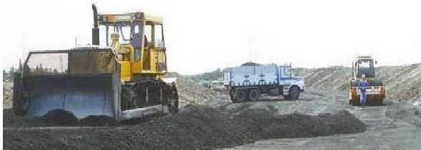
Figur 8: Utläggning av kolrostbottenaska som bankfyllning (Norrköping).
