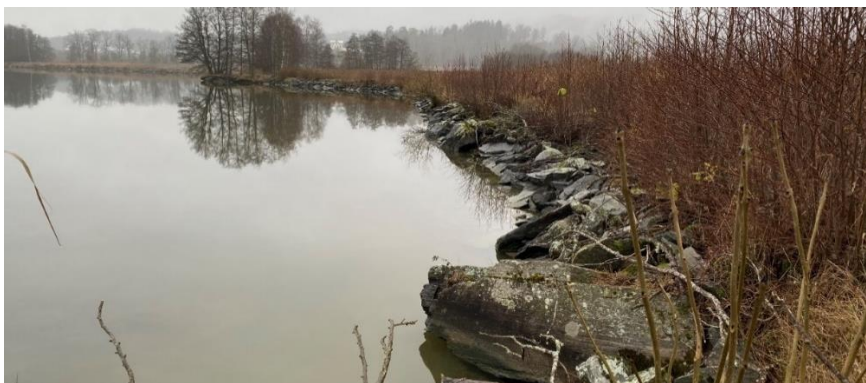
Figur 5.2: Erosionsskydd i form av sprängstensbank längs Göta älv. Fotot är taget i den mellersta delen av området. Fotoriktning mot söder (datum: 2021-11-15).
