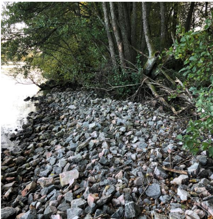
Figur 3 Erosionsskydd längs Göta älv.
