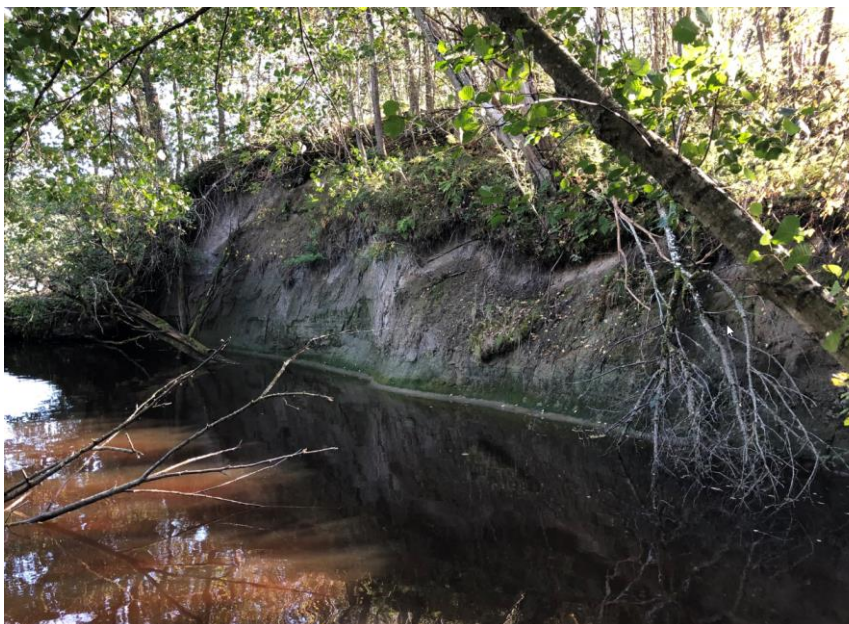
Figur 4 Tydlig erosion i slänten i den östra delen av Sollumsåns södra sida.
