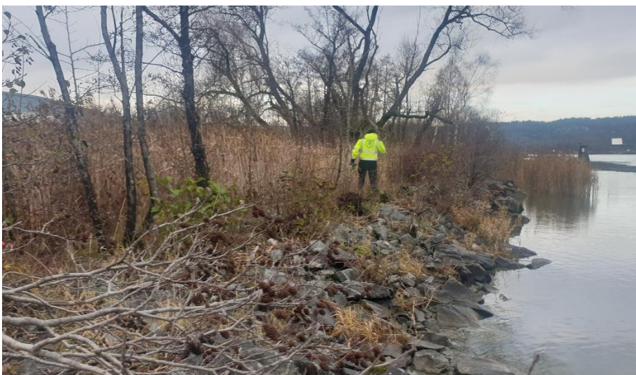
Figur 6-2 Erosionsskydd med bakomliggande vassområde. Fotoriktning mot norr. (Foto från platsbesök 2019-11-14).
