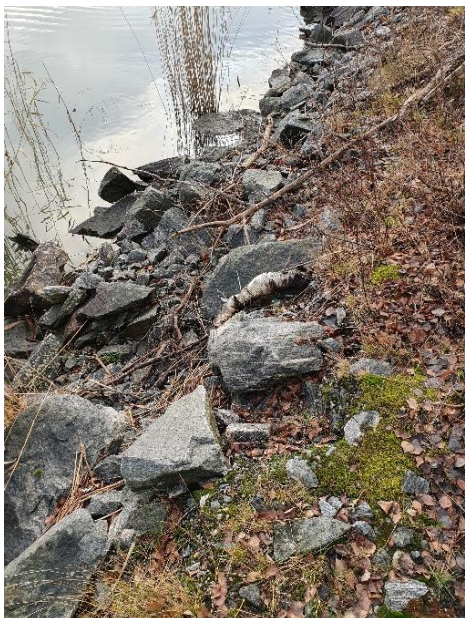
Figur 6-1 Erosionsskydd (bergekross) längs med älvstranden. (Foto från platsbesök 2019-11-14).
