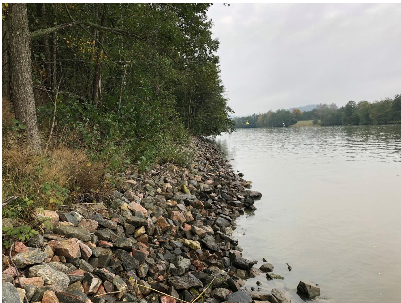
Figur 3: Erosionsskydd i form av sprängstensbank längs Göta älv. Fotot är taget i den västra delen av utredningsområdet. Fotoriktning mot väster (datum: 2020-09-30).
