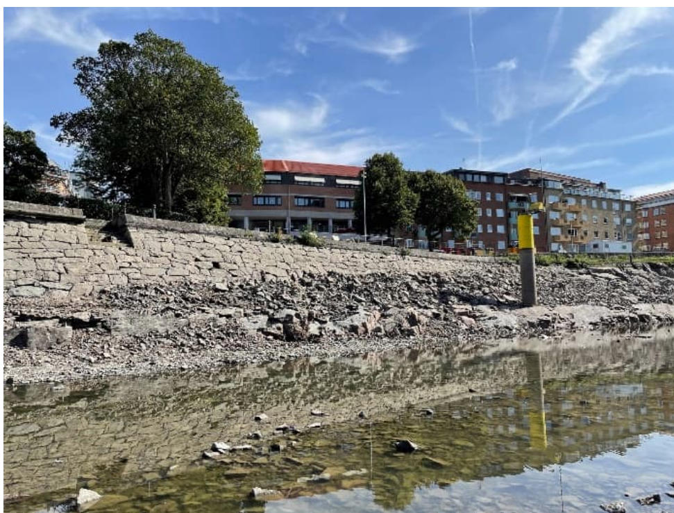
Figur 2: Södra delen av stödmuren. Muren vilar mot stenfyllning och berg där berg i dagen syns i den sydligaste delen. Fotoriktning mot öster. Fotot är taget av Sjöfartsverket under hösten 2021 vid tömningen av Trollhätte kanal.
