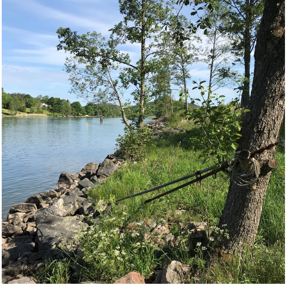
Figur 5. Strandkant med erosionsskydd, vy åt norr (COWI AB, 2020).
