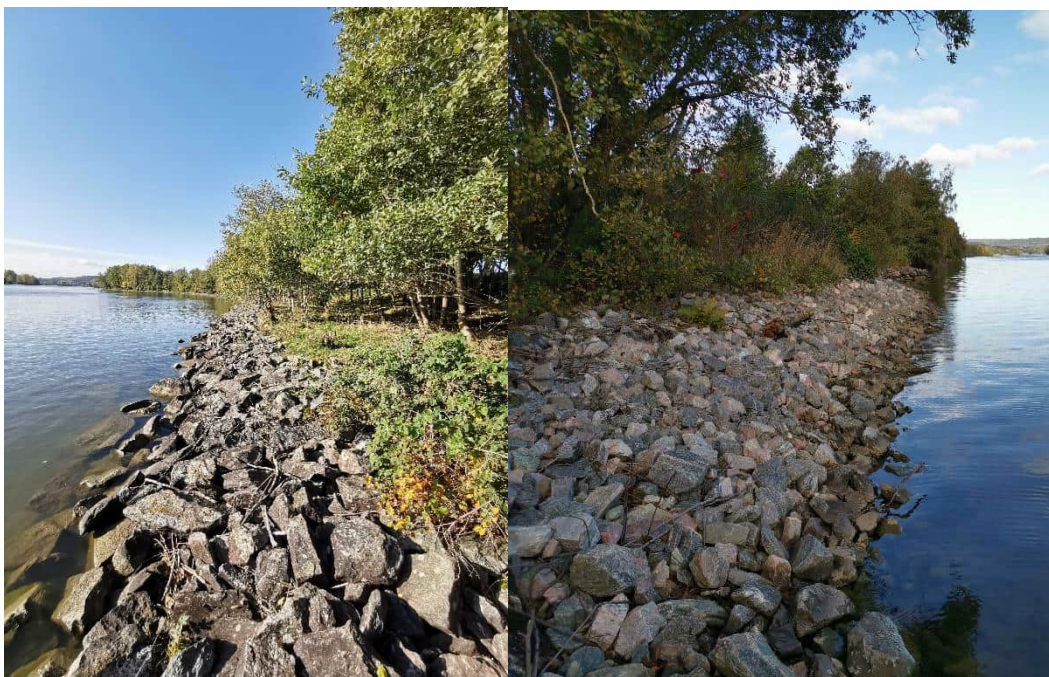
Figur 3 Erosionsskyddet vid vattenbrynet längs Göta älv, södra delen (till vänster i bild) och norra delen (till höger).
