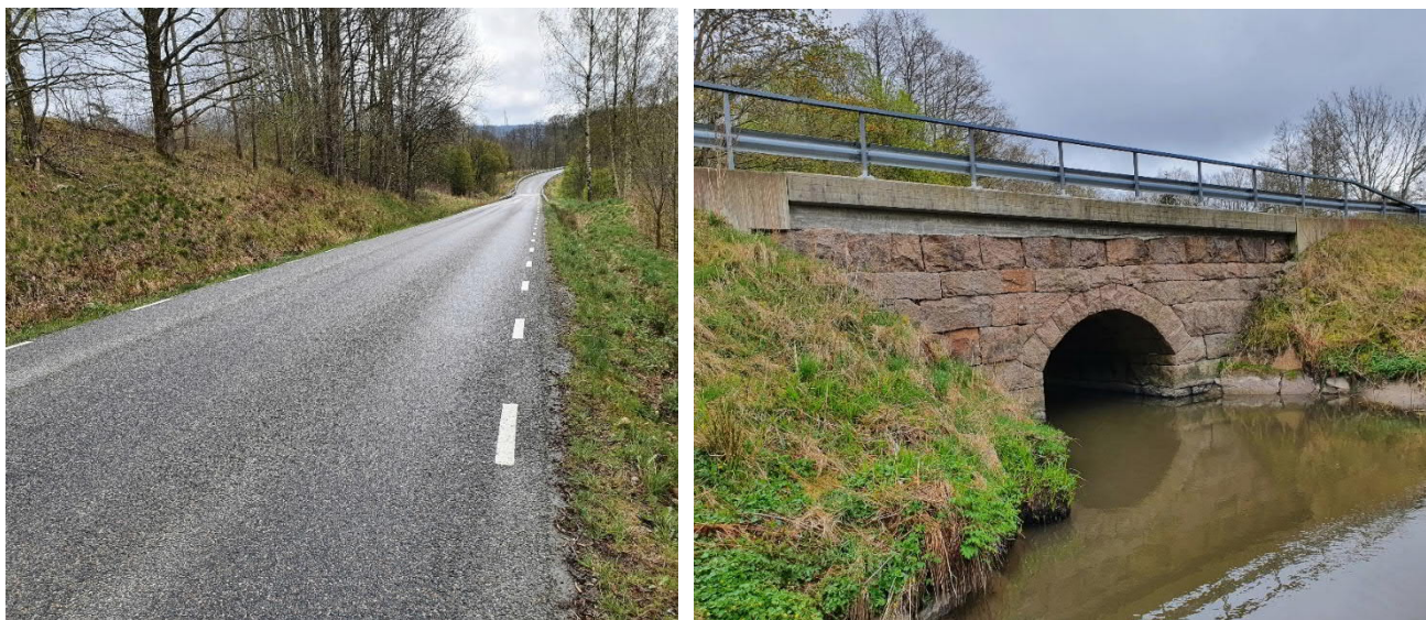
Figur 18 Väg 2025 med bro över Brattorpsån. Fotoriktning mot norr. Datum 2020-04-28.
