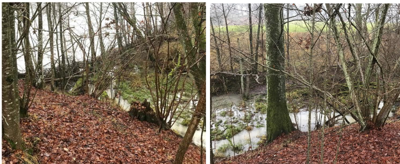
Figur 16 Det södra vattendragets utlopp i Göta älv, med erosionsskydd/sprängstensvall längs älven. Begränsat flöde och erosion, men lokalt bar jord och nedfallna träd i öster. Fotoriktning mot söder, 2019-11-27.
