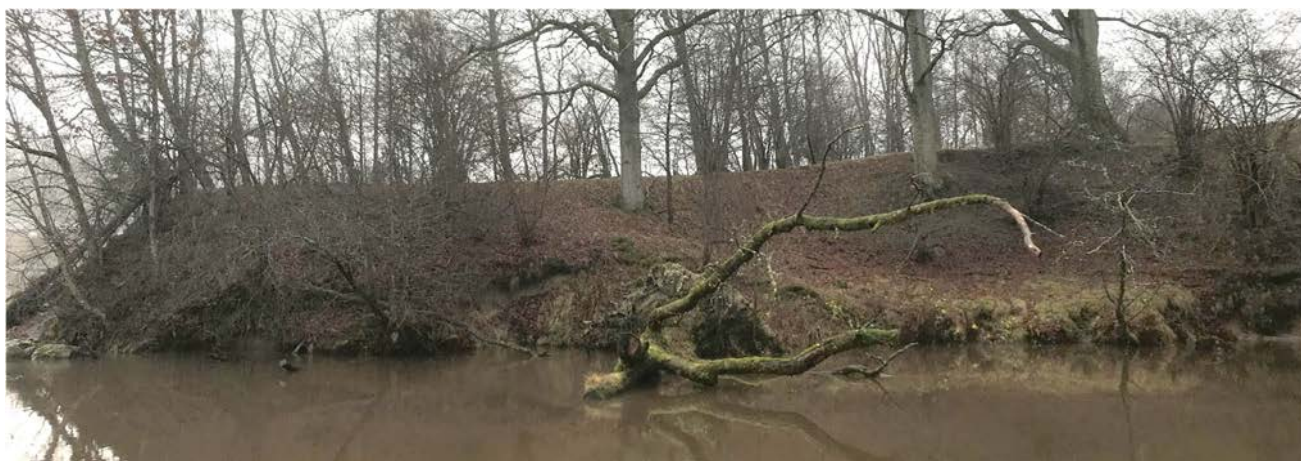
Figur 12: Pågående erosion längs Brattorpsåns södra strandkant, ca 50-100 m väster om utloppet i Göta älv. Fotoriktning mot söder, 2019-11-27.
