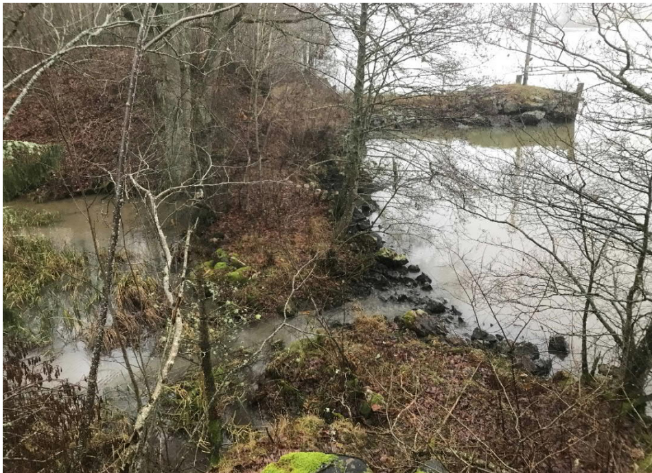
Figur 9: Erosionsskydd/sprängstensvall tvärs den norra bäckens utlopp i Göta älv. Fotoriktning mot norr, 2019-11-27.
