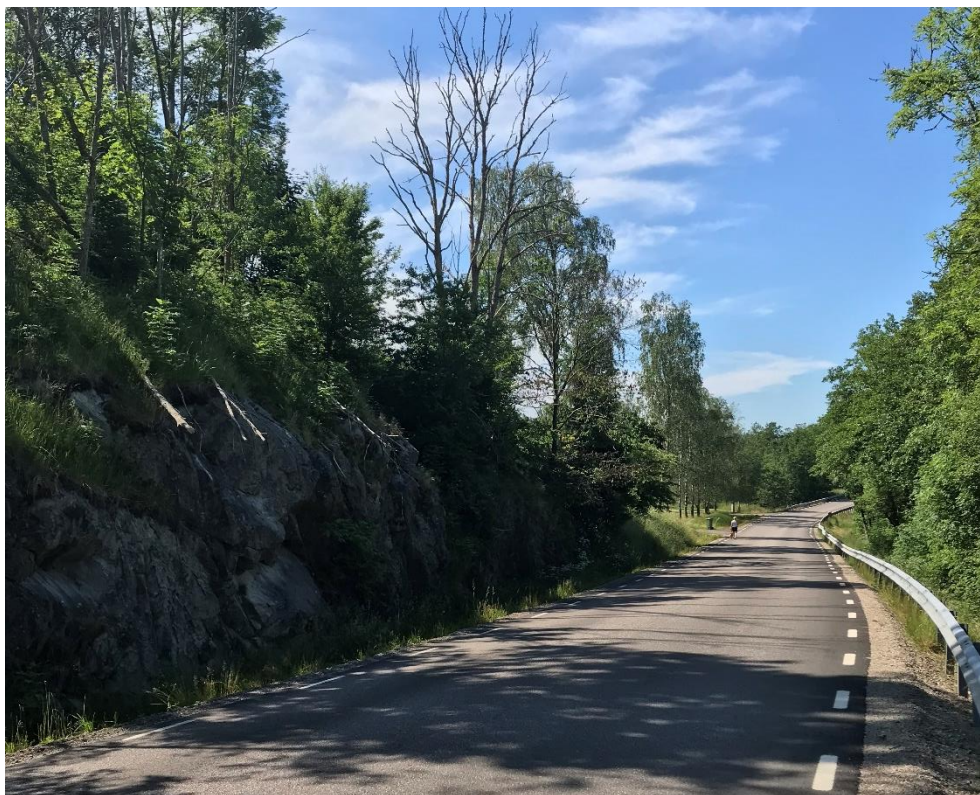
Figur 6. Berg i dagen intill Edsvägen (COWI AB, 2020)
