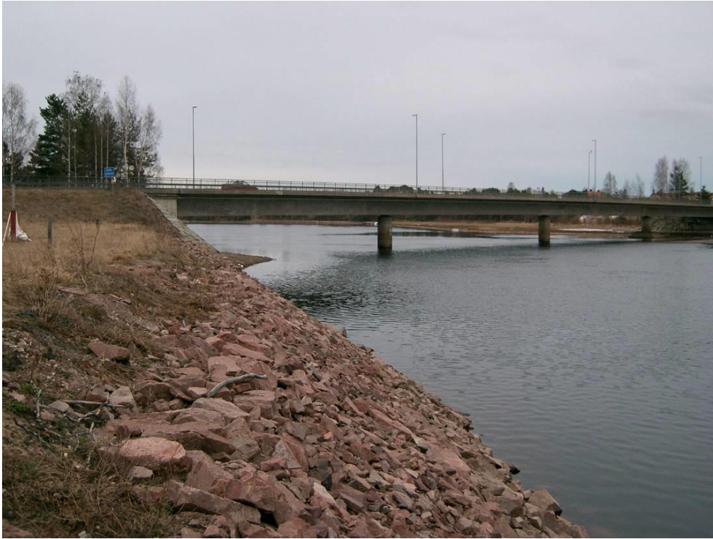
Figur 4-7. Erosionsskydd med strandskoning med sprängsten utmed Österdalälven i Mora. Foto: SGI
