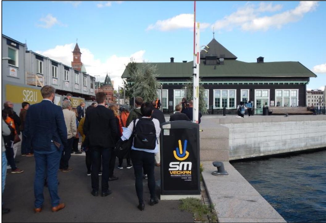
Figur 3.9 I SeaU, Helsingborgs nya mötesplats, har staden använt höjsättning av färdiggolvnivå som översvämningsstrategi. Foto: Karin Bergdahl.
