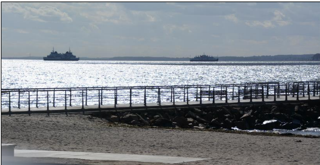
Figur 3.7 Strandvägen i Helsingborg drabbas återkommande av översvämning. Foto: Anette Björlin
