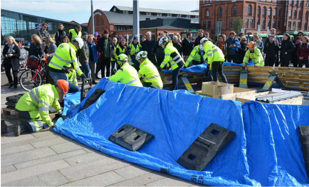
Figur 3.3 Posthusplatsen vid Malmö centralstation. Kommunteknik och Fastighets- och gatukontoret vid Malmö stad byggde upp portabla översvämningsskydd för citytunneln. Foto: Anette Björlin
