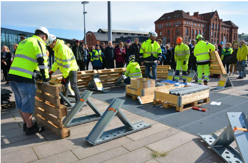
Figur 3.2 Posthusplatsen vid Malmö centralstation. Kommunteknik och Fastighets- och gatukontoret vid Malmö stad byggde upp portabla översvämningsskydd för citytunneln. Foto: Anette Björlin
